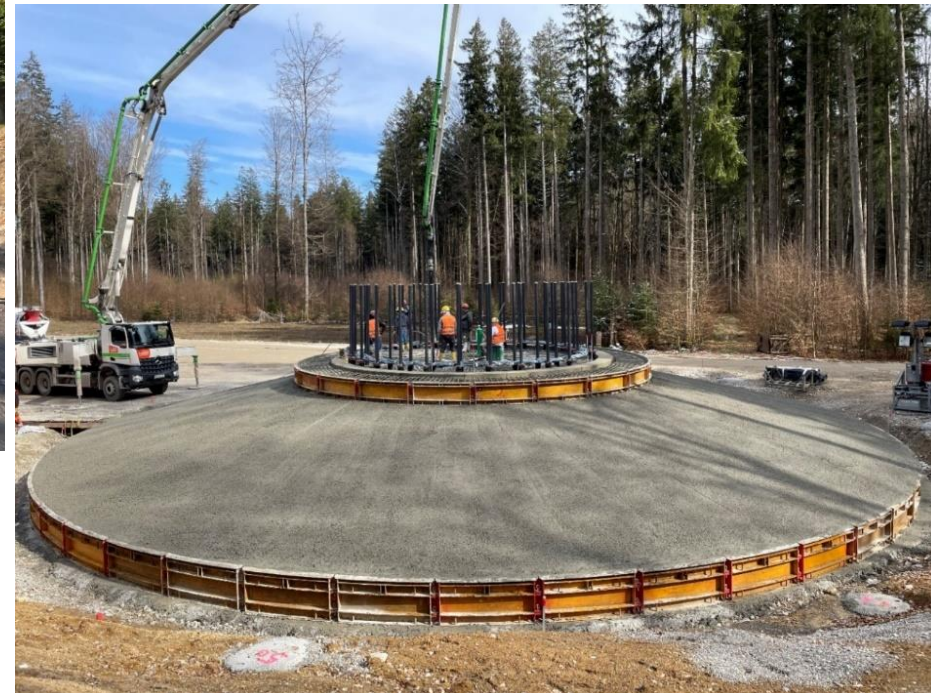
Abbildung: Betonage im April 2023 auf der WEA-Baustelle in der Gemeinde Fuchstal
