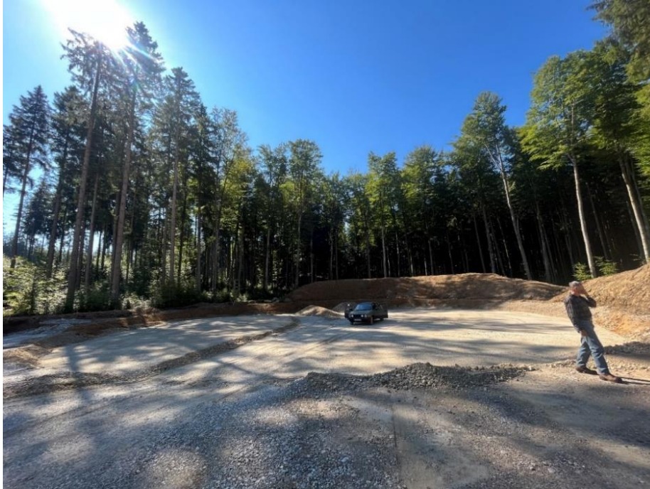
Abbildung: Vorbereitete Fundamentfläche in der Gemeinde Fuchstal
